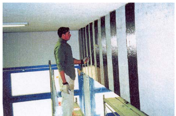
Bild 15 Querkraftverstärkung durch Umschließung des Steges
